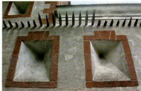
Trostburg, Eingangsfassade, minimale Ergänzung der Sturmpfähle
