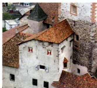
Trostburg, „Neueindeckung“ mit alten Biberschwanzziegel
